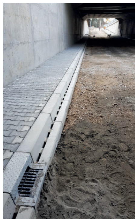
Przepust Kolejowy Otwock AS-S200 K
